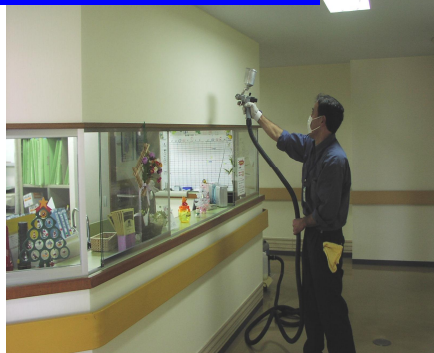
通路・ステーション内
